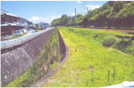
改修された淵の川
