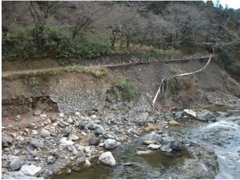
丹生川まで降りてくると、橋の向こう側の車道が大きくえぐられ、ガードレールが垂れ下がったままになっている光景を目の当たりにした。よく見ると、橋の上流にあるコンクリートの砂防ダムの車道側の片方が根元を侵食されたのか、完全に崩壊していて大水の威力のすごさを物語っている。車道は車の幅でアスファルト部分は残っているも
